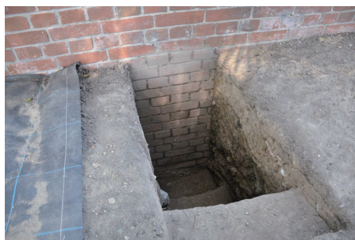
図8 橋台前面の擁壁根入れ状況（南より） 地中構造物が1.1m以上入っていることを確認
