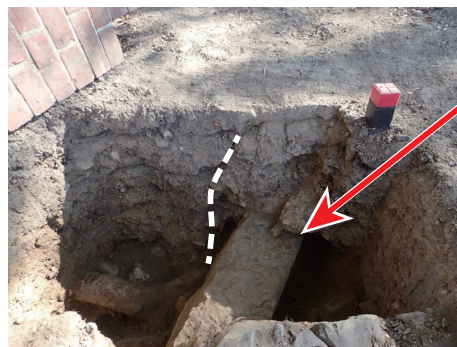
図9 西橋脚抜き取り穴と根枷の石材（西より） 破線は抜き取り穴の掘り方。左は抜き取り穴の埋土
