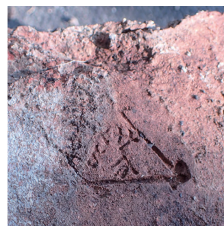
図10 橋台に使用されたレンガの刻印
